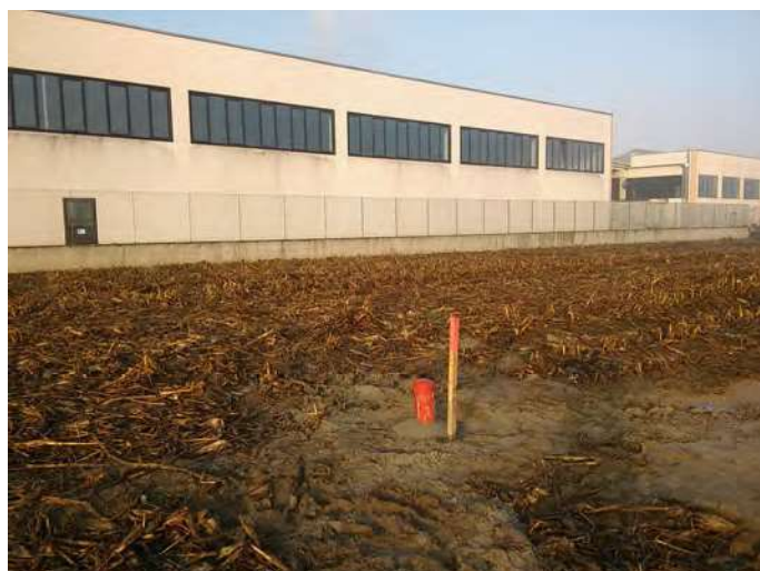
Completamento piezometro su S2
