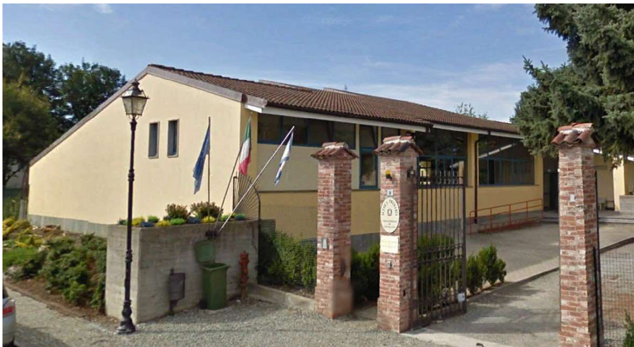
Vista del fabbricato dalla via Pellico - Accesso
