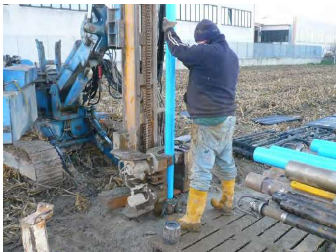
Posa piezometro a tubo aperto diam. 3"
