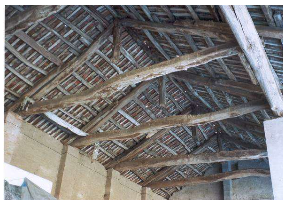
Negativo fotografico n° 16 - Orditura copertura tettoia
