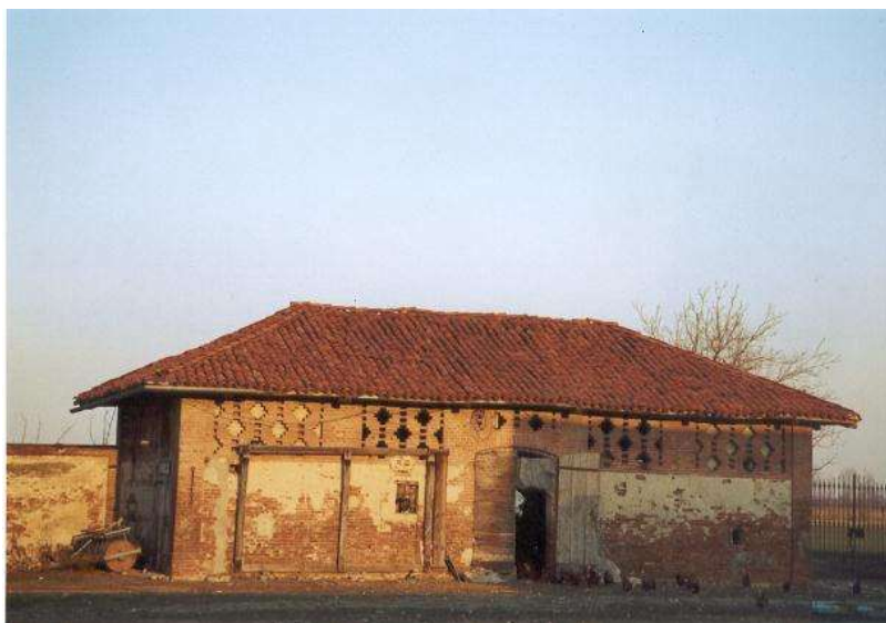
Negativo fotografico n°14A - Tettoia perimetro est
