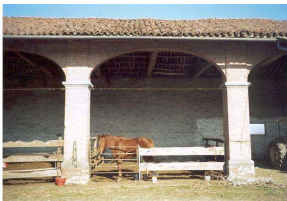
Negativo fotografico n°16 - Orditura tettoia
