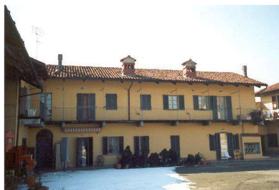
Negativo fotografico n° 05 - Prospetto su cortile interno
