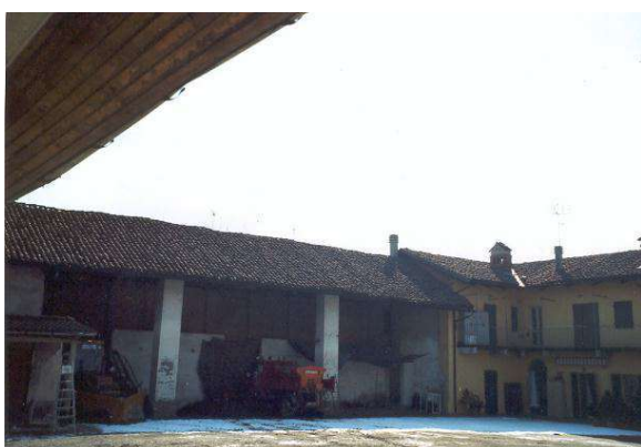
Negativo fotografico n° 07 – Tettoia
