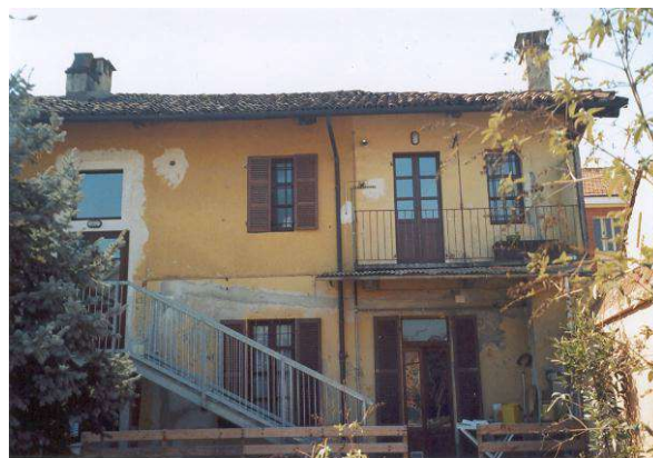
Negativo fotografico n° 03 - Prospetto su cortile interno
