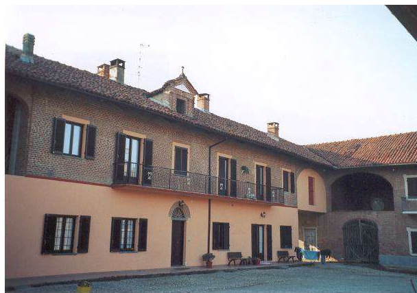
Negativo fotografico n°14 - Particolare fronte interno N-W
