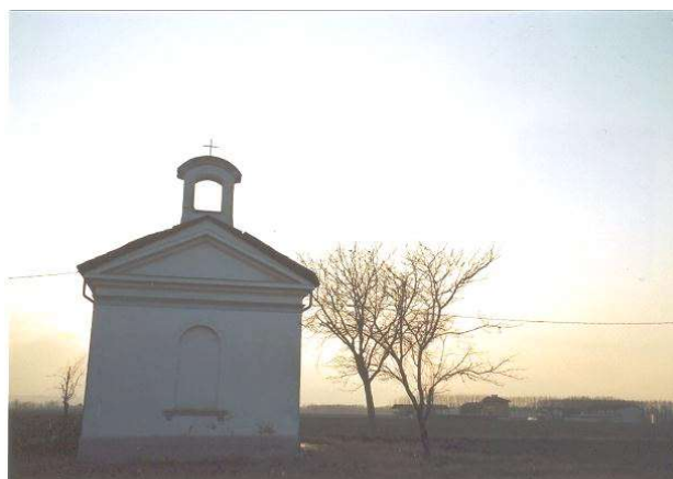
Negativo fotografico n° 19A – Prospetto est
