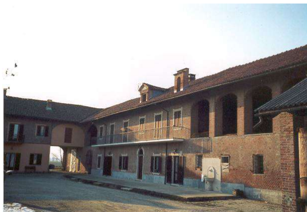
Negativo fotografico n° 18 - Scorcio fronte nord
