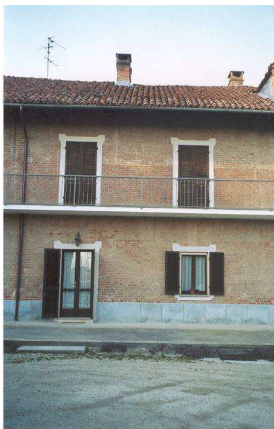
Negativo fotografico n° 16 - Particolare cornici fronte nord
