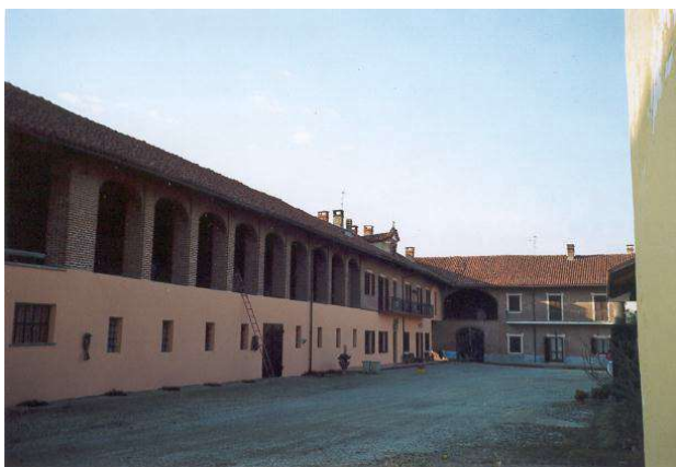
Negativo fotografico n°13 - Scorcio prospetto interno N-W
