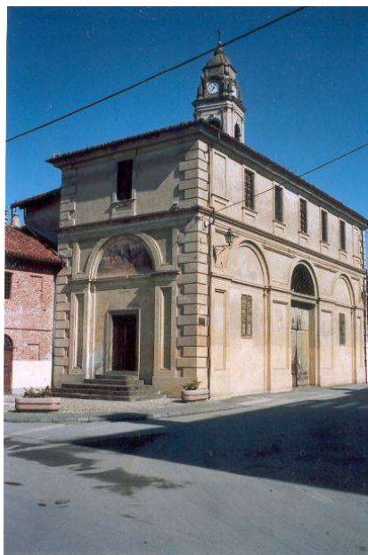
Negativo fotografico n° 12 - Scorcio sud-ovest
